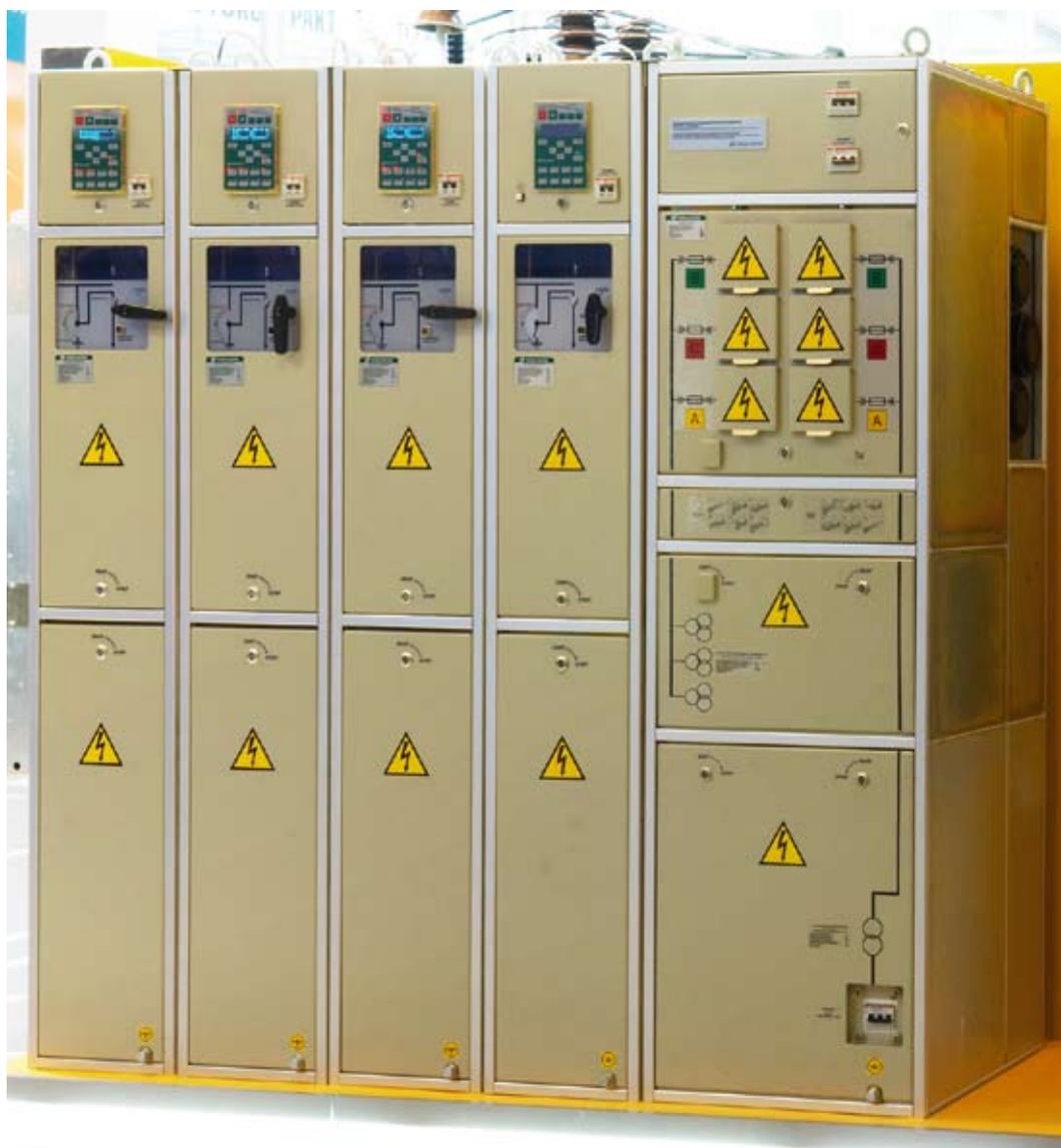
**Рис. 4.** Секция шкафов КРУ/TEL серии «Эталон» производства компании «Таврида Электрик»
