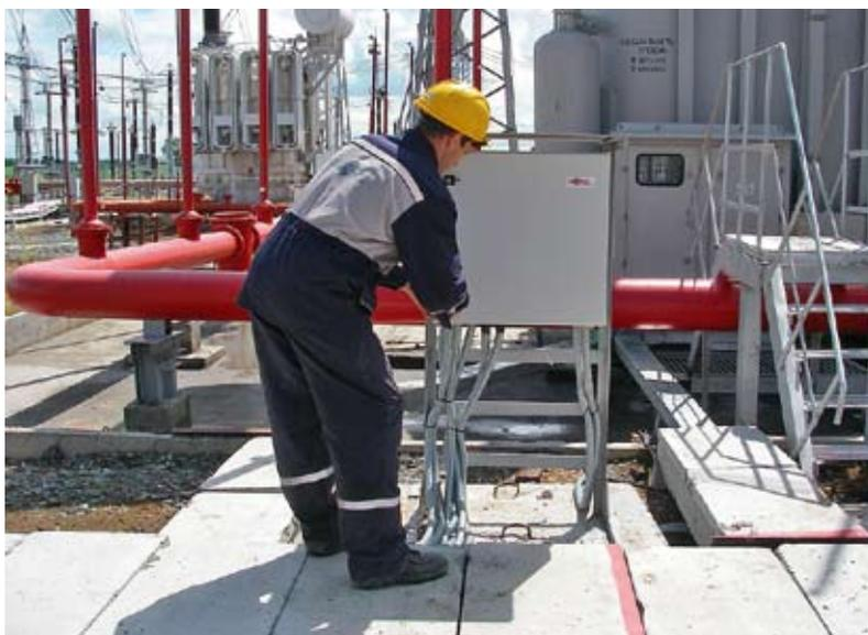
**Блок мониторинга, устанавливаемый рядом с контролируемым объектом**
