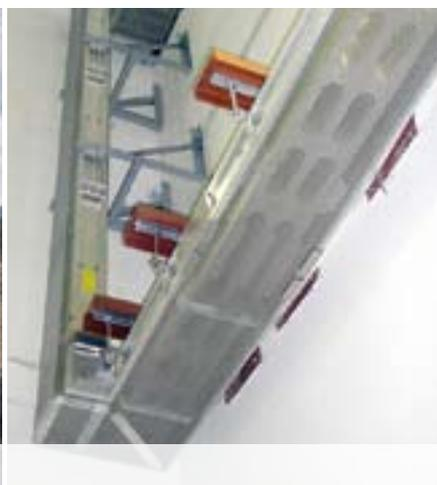
Сегодня компания «РТК-ЭЛЕКТРО-М» выполняет полный цикл работ по оснащению любых объектов токопроводами с литой изоляцией,
