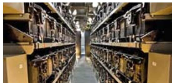
Рис. 4. Буферный/резервный литий-ионный накопитель энергии компании Altair-nano емкостью 250 кВтч и мощностью 1 МВт
