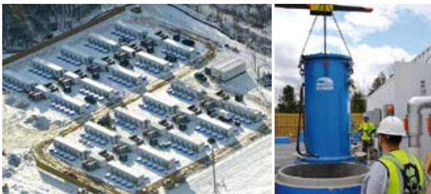
**Рис. 11.** Строительство завода мощностью 20 МВт в Stephentown, Нью-Йорк. После завершения завод будет в непрерывном режиме сохранять и возвращать в сеть электроэнергию, что обеспечит примерно 10 % от общих потребностей Нью-Йорка в регулировании частоты
