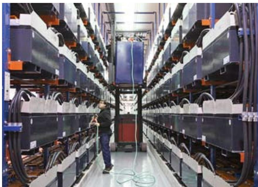
Рис. 2. Аварийный источник питания для городской энергосистемы г. Fairbanks (Аляска, США). 40 МВт, 4,7 МВт·ч
