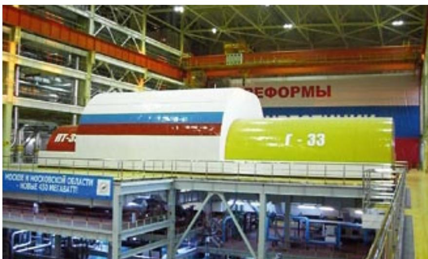
Асинхронизированный турбогенератор типа ТЗФАУ-160-2 на энергоблоке № 3 ТЭЦ-27 «Мосэнерго»
