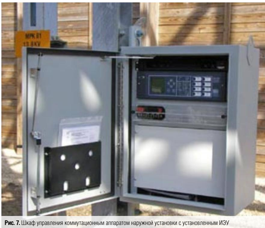
Рис. 7. Шкаф управления коммутационным аппаратом наружной установки с установленным ИЭУ
