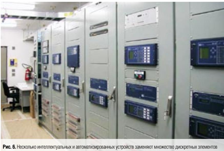
Рис. 6. Несколько интеллектуальных и автоматизированных устройств заменяют множество дискретных элементов
